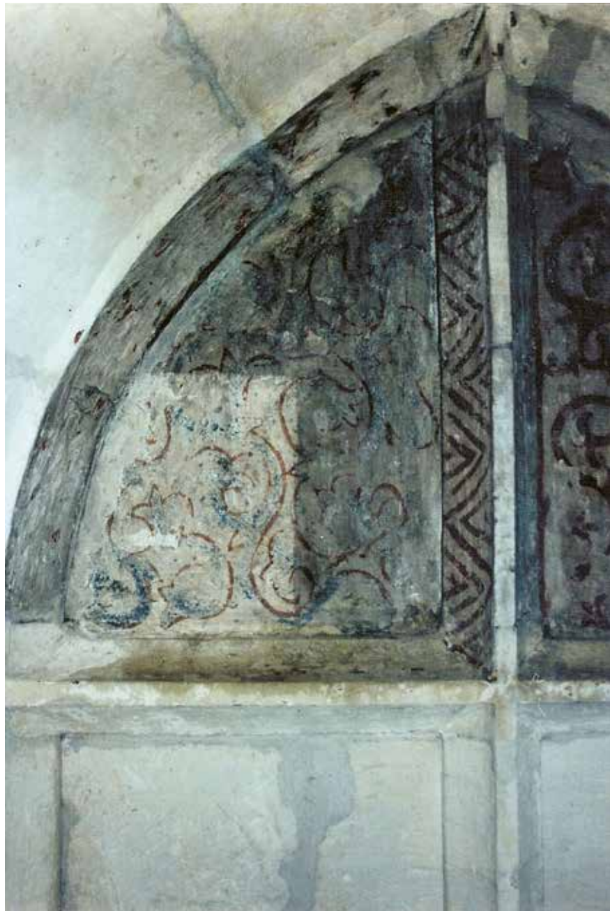
Fot. 6. Próba oczyszczania malowidła, fot. J. Rościszewska
