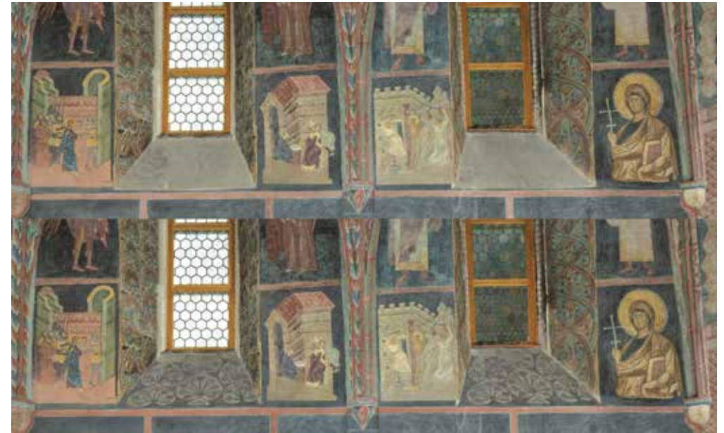
Rys. 6. Parapety okien – cyfrowe uzupełnienie ubytków polichromii. Góra: stan przed uzupełnieniem, dół: stan po uzupełnieniu
