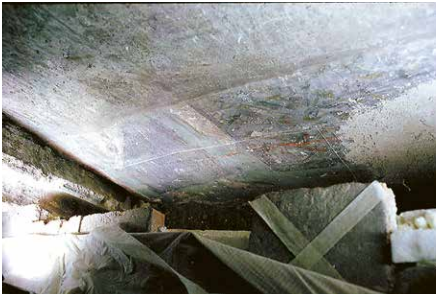
Ilustr. 15. Kraków, katedra na Wawelu, kaplica Mariacka, rozebrana część posadzki empory, poniżej której znajduje się malowidło bizantyńsko-ruskie. Konserwacja Władysława Zalewskiego
