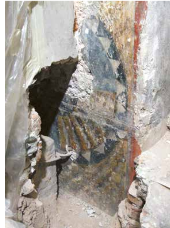
Ilustr. 17. Kraków, katedra na Wawelu, kaplica Mariacka, nieznane fragmenty malowideł bizantyńsko-ruskich odkryte poniżej rozebranej części posadzki empory oraz zamurowania arkady. Konserwacja Władysława Zalewskiego
