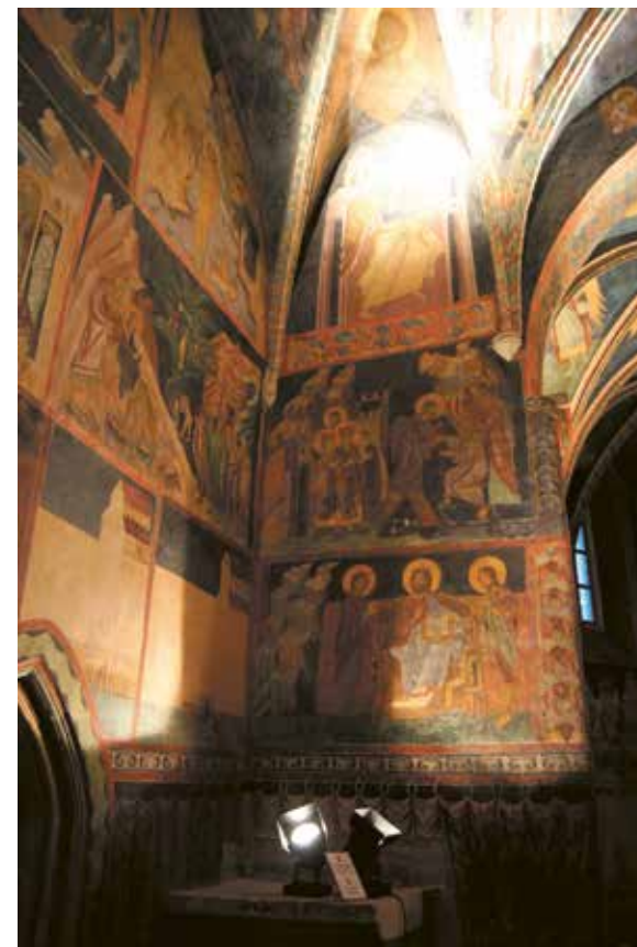
Rys. 21. Sposób oświetlenia ściany
