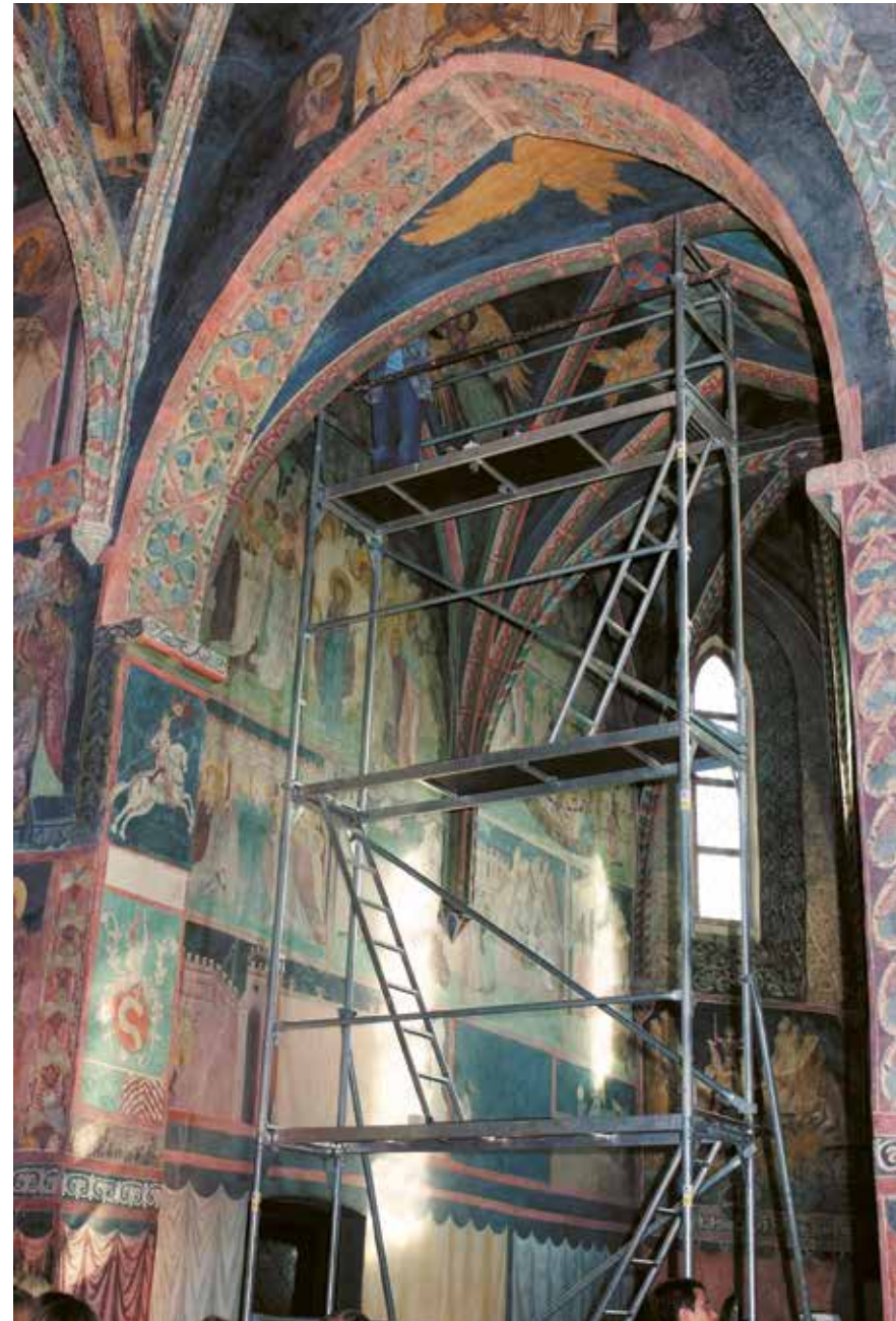
Fot. 1. Prace konserwatorskie w 2008 roku w prezbiterium kaplicy Trójcy Świętej, fot. P. Maciuk
