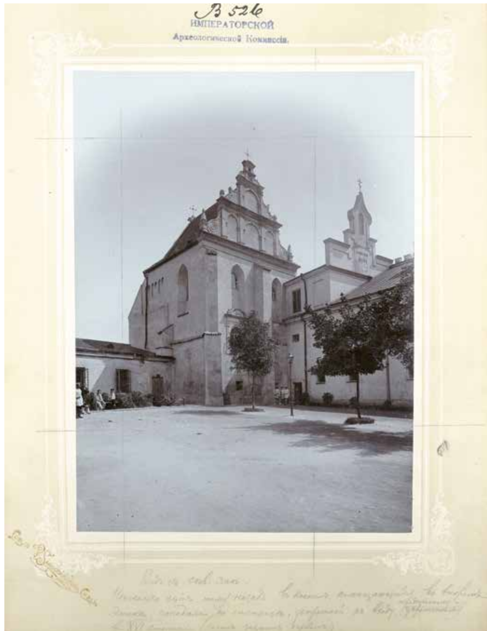
Fot. 5. Kaplica Trójcy Świętej, 1904, dokumentacja kaplicy
