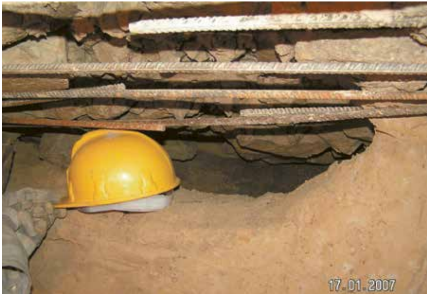
Rys. 1. Widok kawerny pod fundamentem kaplicy
