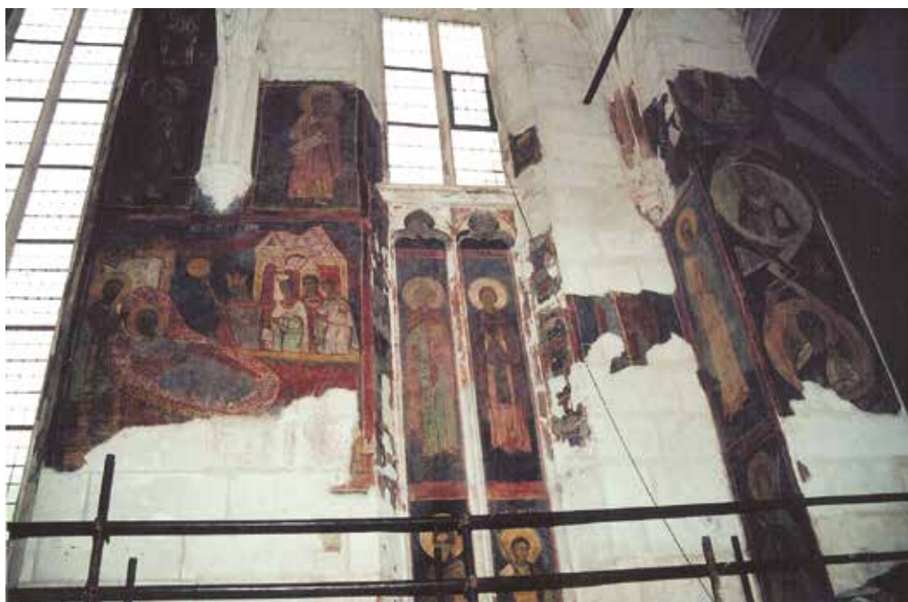
Fot. 12. Zachodnia część ściany południowej po konserwacji, fot. M. Stec
