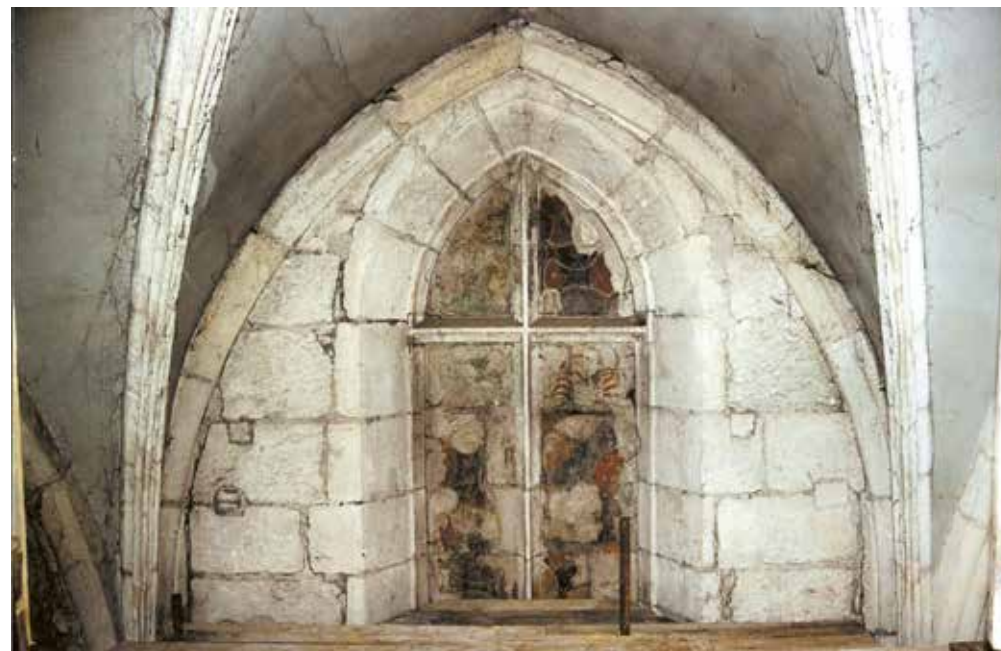
Fot. 7. Stan kamieniarki przed konserwacją, fot. M. Stec
