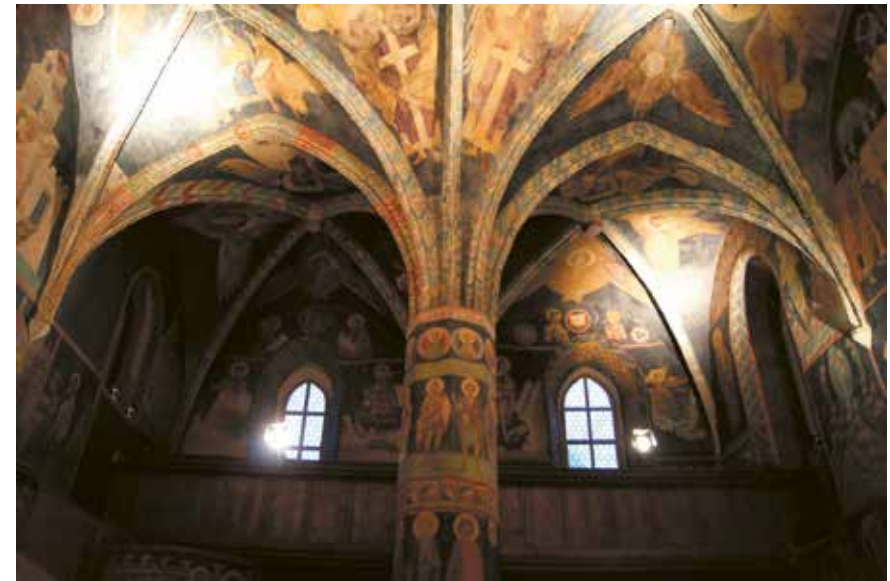
Rys. 20. Sposób oświetlenia sklepienia
