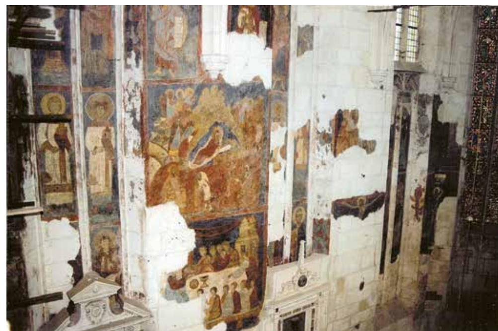
Fot. 14. Wschodnia część ściany północnej po konserwacji, fot. M. Stec
