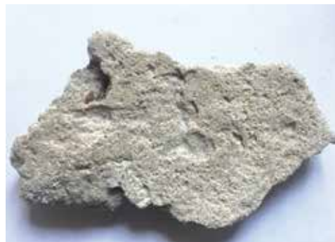
Fot. 7. Próbk nr 7 - tynk z klatki schodowej południowej (górny spocznik)
