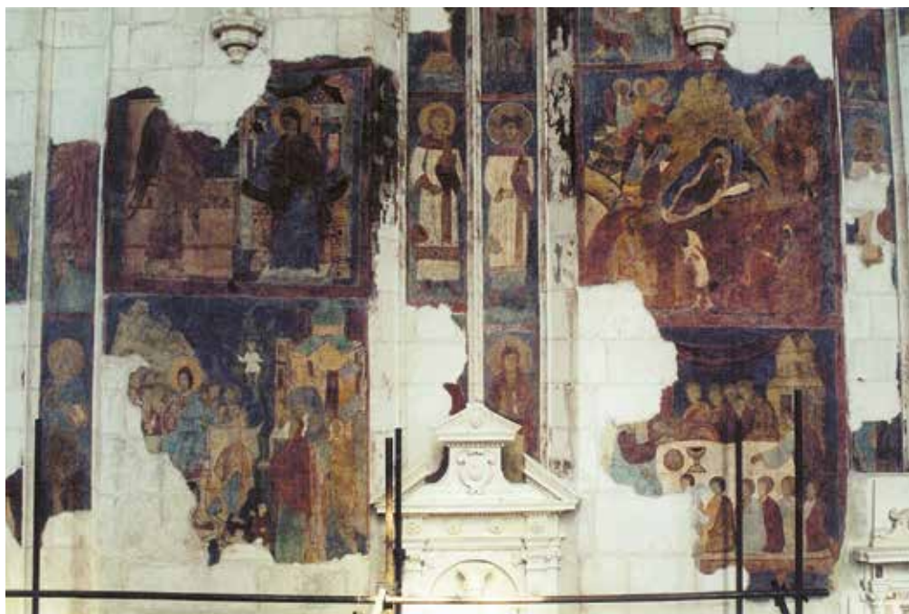
Fot. 13. Zachodnia część ściany północnej po konserwacji, fot. M. Stec
