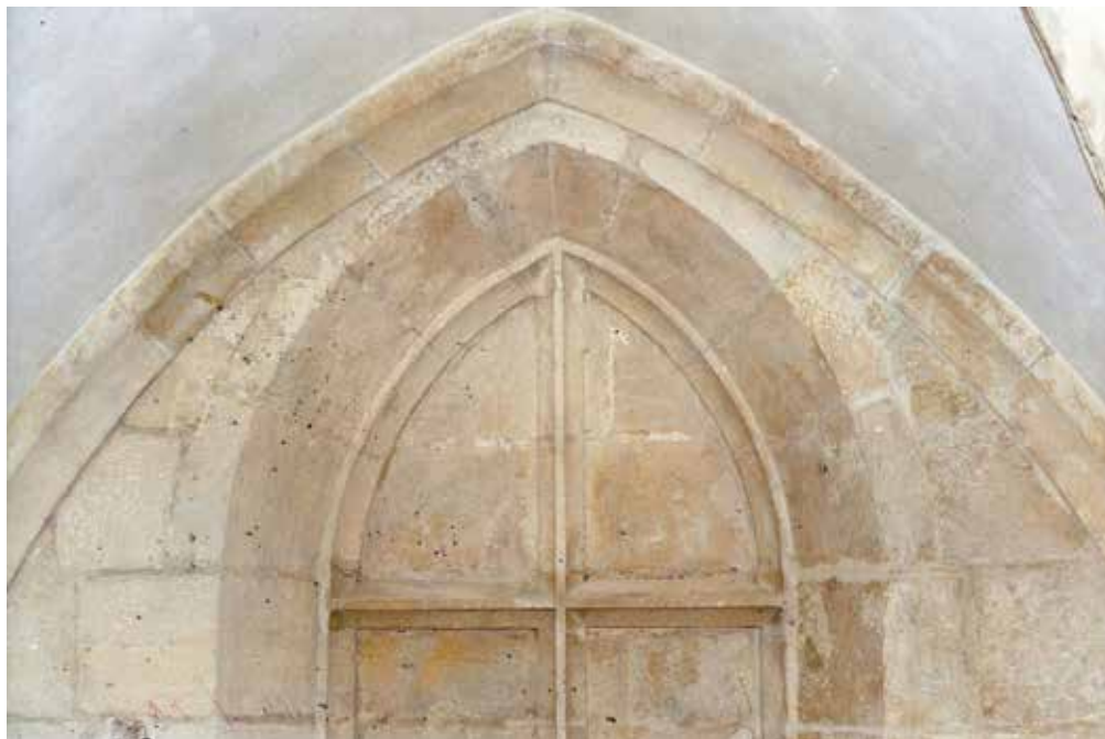
Fot. 16. Zabliendowane okno na ścianie północnej po konserwacji, fot. M. Stec
